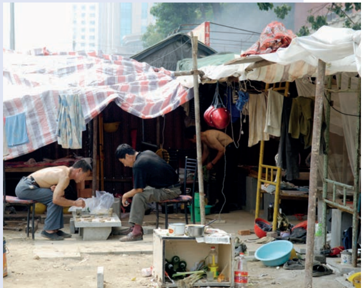
Provisorische Unterkunft von WanderarbeiterInnen auf einer Baustelle in Peking, China, Foto: ILO/Flickr.com
