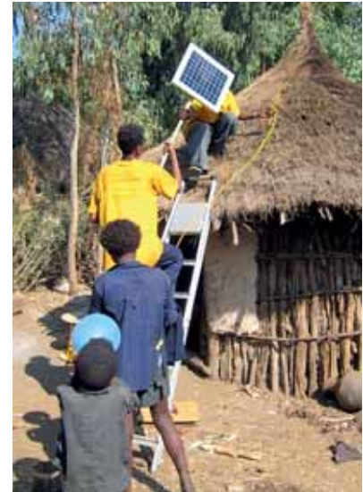
Kleinversorgung mit Solarenergie in Äthiopien (Foto: Stiftung Solarenergie)
